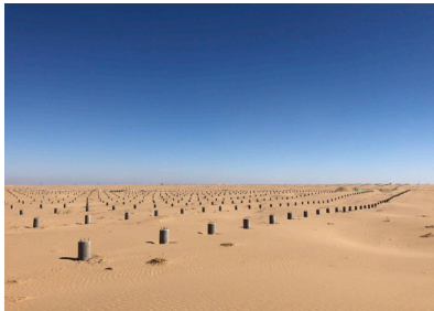
▲ 已铺设完毕的支家桩基础
