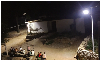
▲ 安装太阳能光伏发电节能路灯
