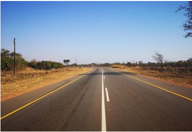
▲ 承担赞比亚 T005 公路项目，施工工艺先进、质量控制严格，有效解决了交通运输瓶颈问题，吸引了非洲多国领导前来考察
