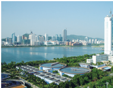
▲ 福建厦门市政污水处理项目
