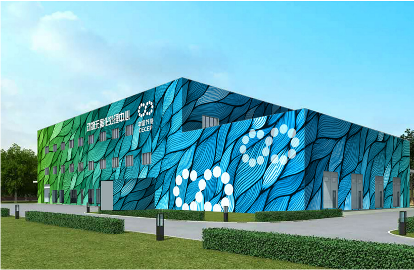
▲ 临沂多种废弃物循环处理产业园：动物无害化处理项目
