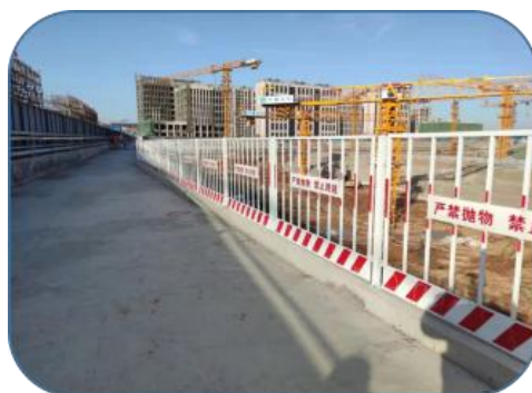
图 45 基坑防护
