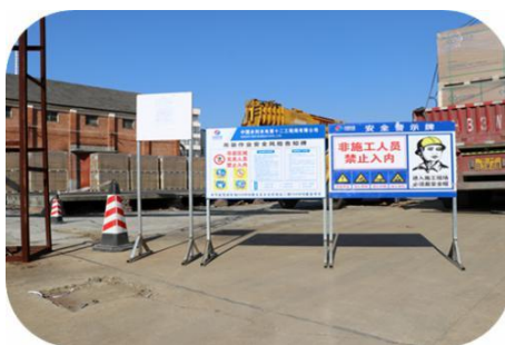
图 65 吊装作业准备
