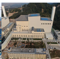
中国环保 潮南生活垃圾焚烧 发电厂扩建项目
